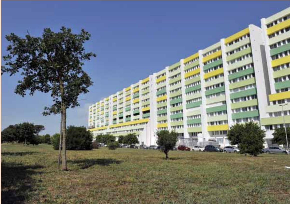
Ospedale Perrino di Brindisi
